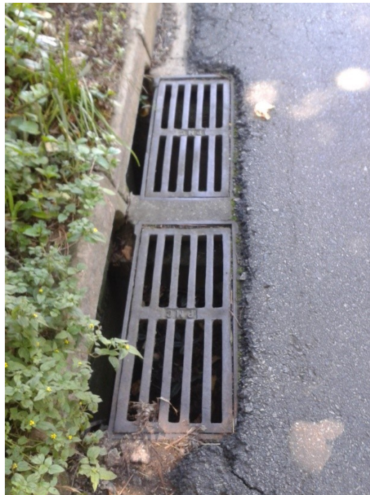
Figura 8 - Boca de Lobo Combinada e Múltipla
