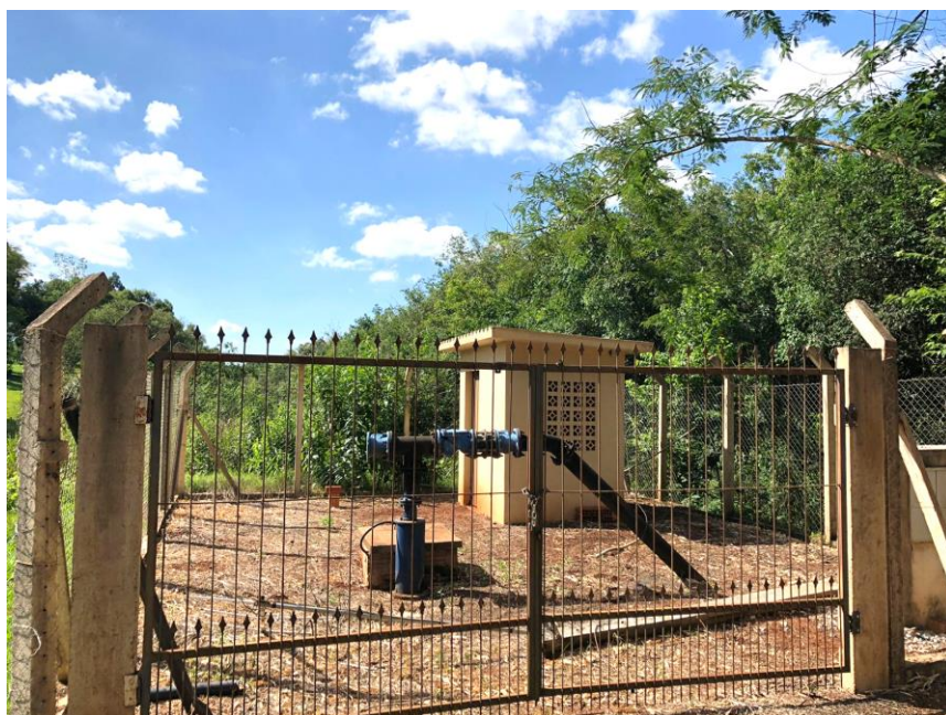
Figura 8 - Vista Externa do Poço Lageado
