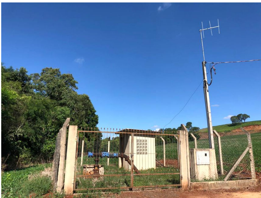
Figura 7 - Vista Externa do Poço Guaçu.
