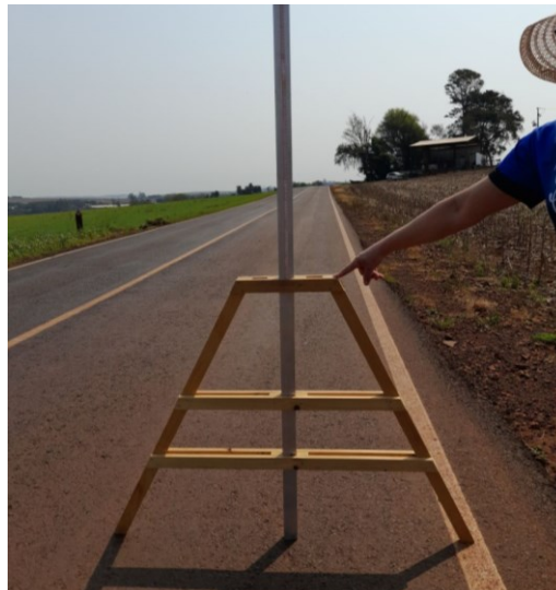
Figura 17 - Medição dos Afundamentos em trilhas de roda com auxílio de Treliça.
