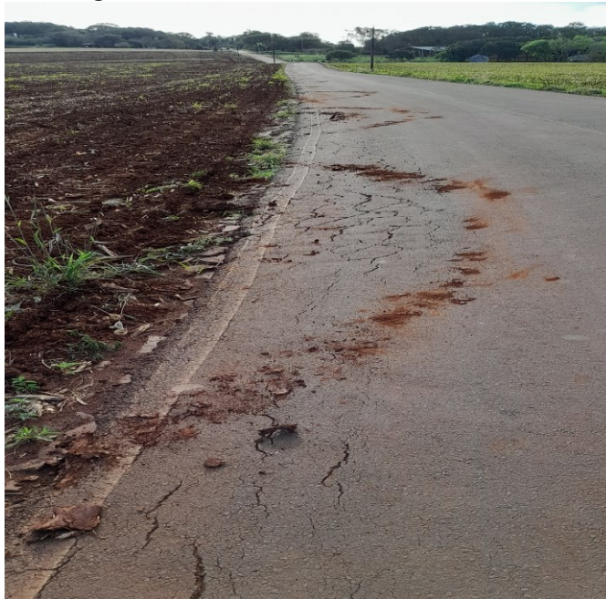
Figura 22 – Defeitos nas bordas.
