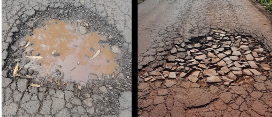
Figura 10 - Panela/Buraco
