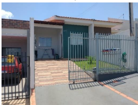
Fotografia 1 - Fachada da primeira obra em estudo
