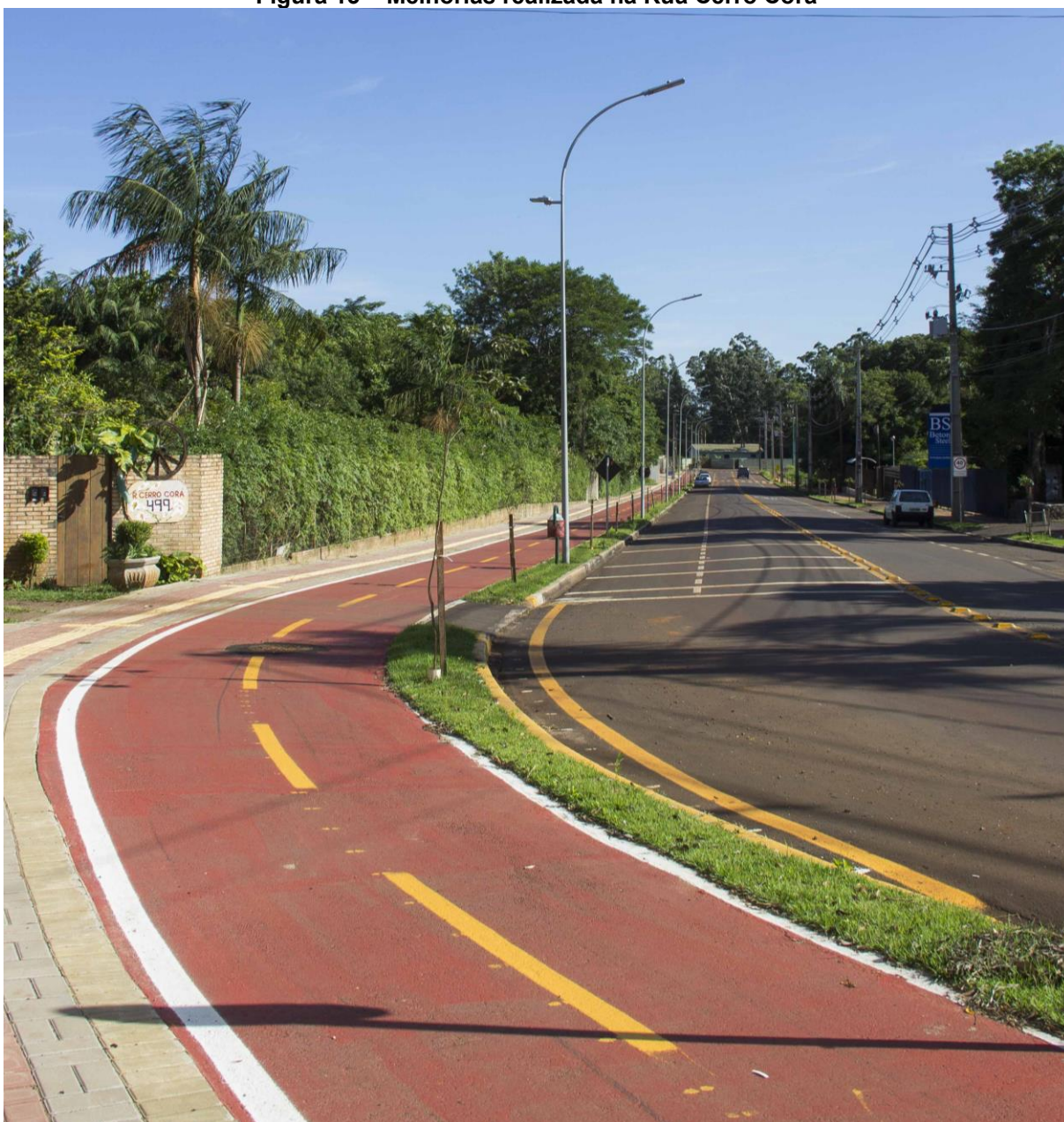
Figura 13 – Melhorias realizada na Rua Cerro Corá
