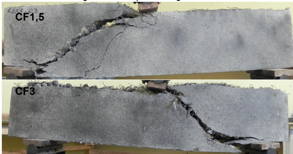
Figura 15 - Colapso das vigas de CRF.
