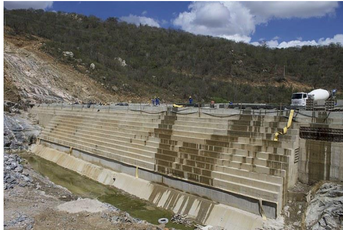
Figura 4 - Exemplo de Construção de Barragem em CCR
