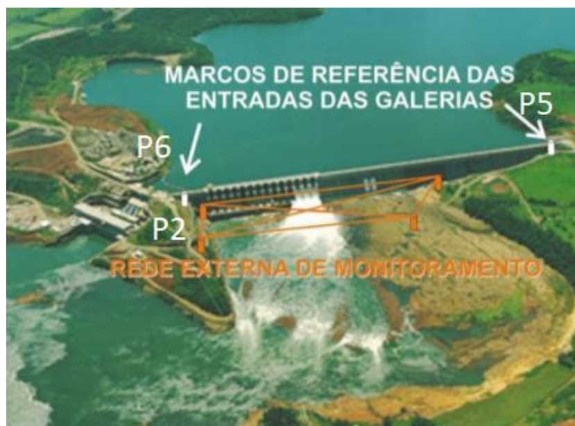
Figura 10 - Rede Geodésica de monitoramento e pilares de referência
