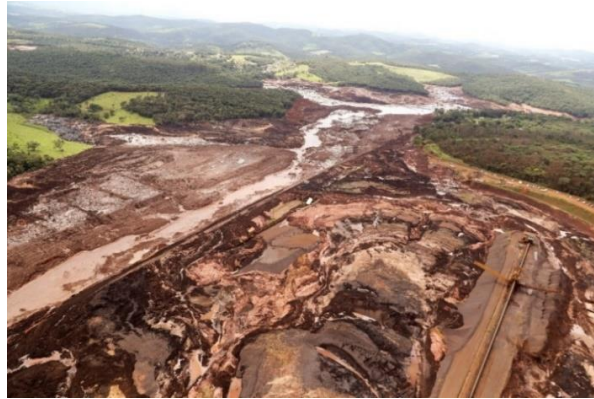
Figura 2 – Consequências do Rompimento da Barragem de Brumadinho
