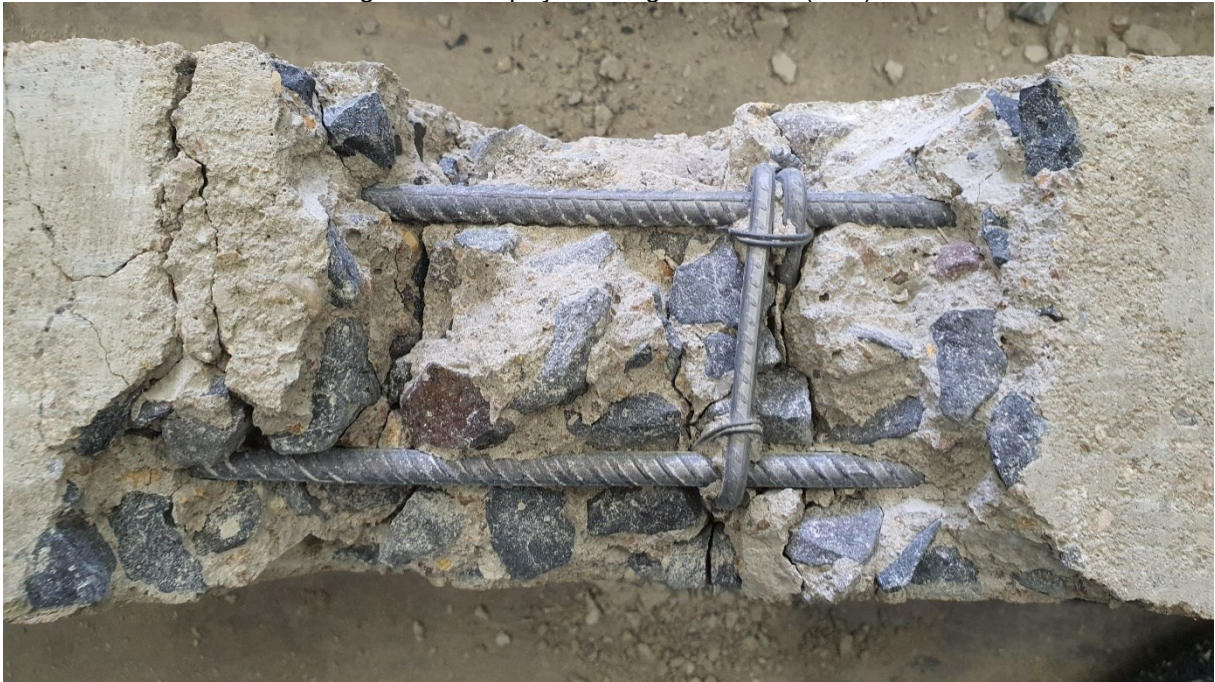
Figura 47 - Inspeção da viga amarrada (V1A).
