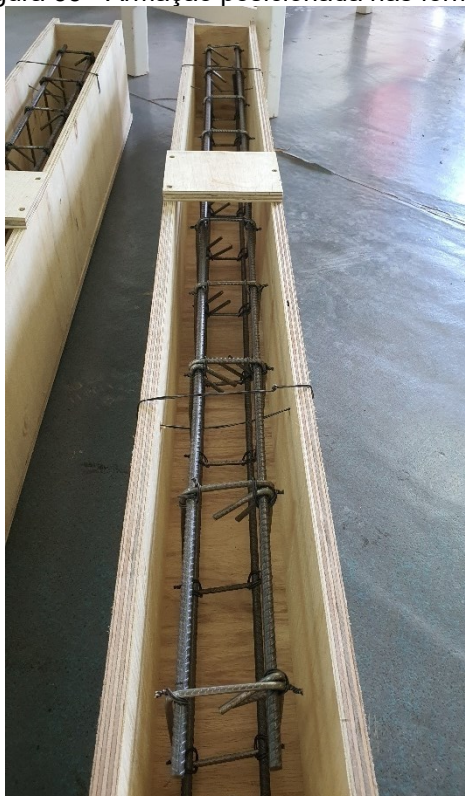
Figura 35 - Armadura posicionada nas formas.
