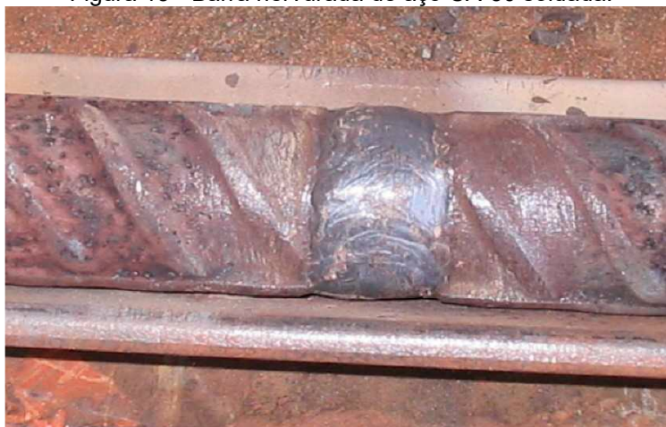
Figura 13 - Barra nervurada de aço CA-50 soldada.
