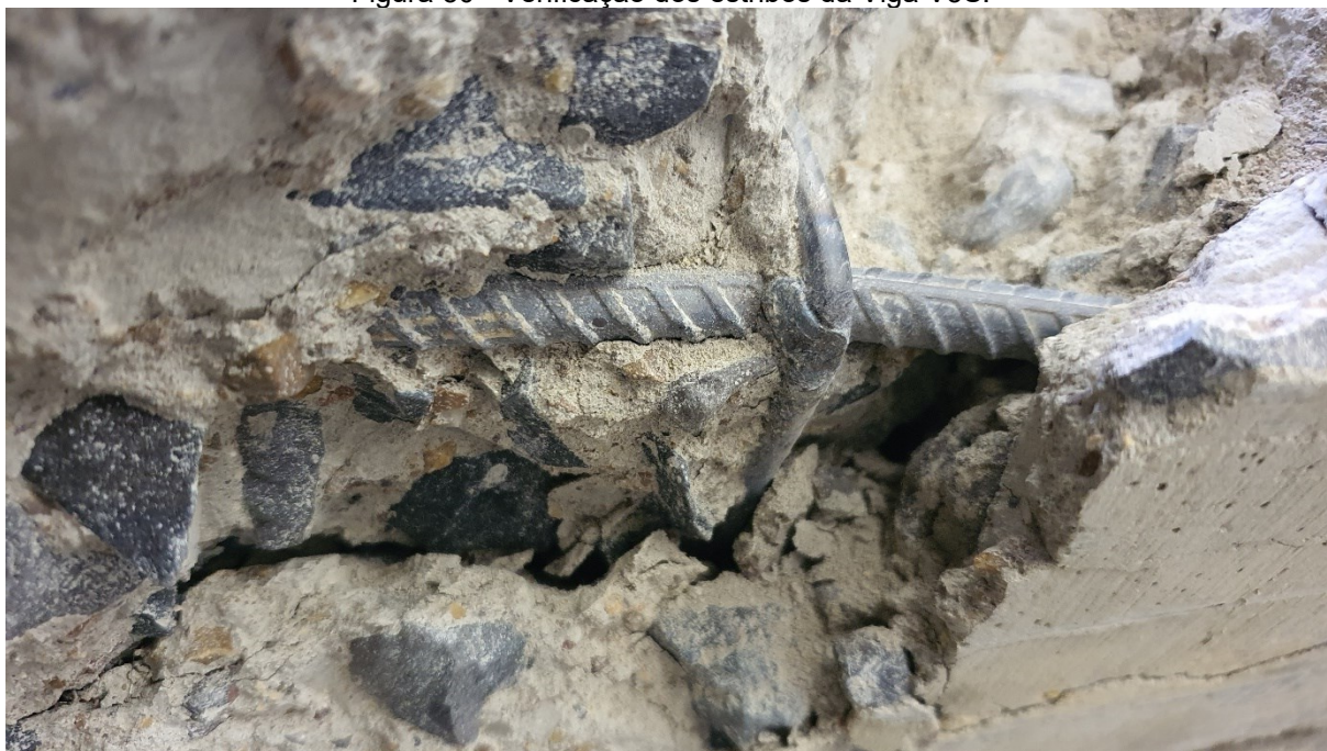
Figura 50 - Verificação dos estribos da Viga V5S.
