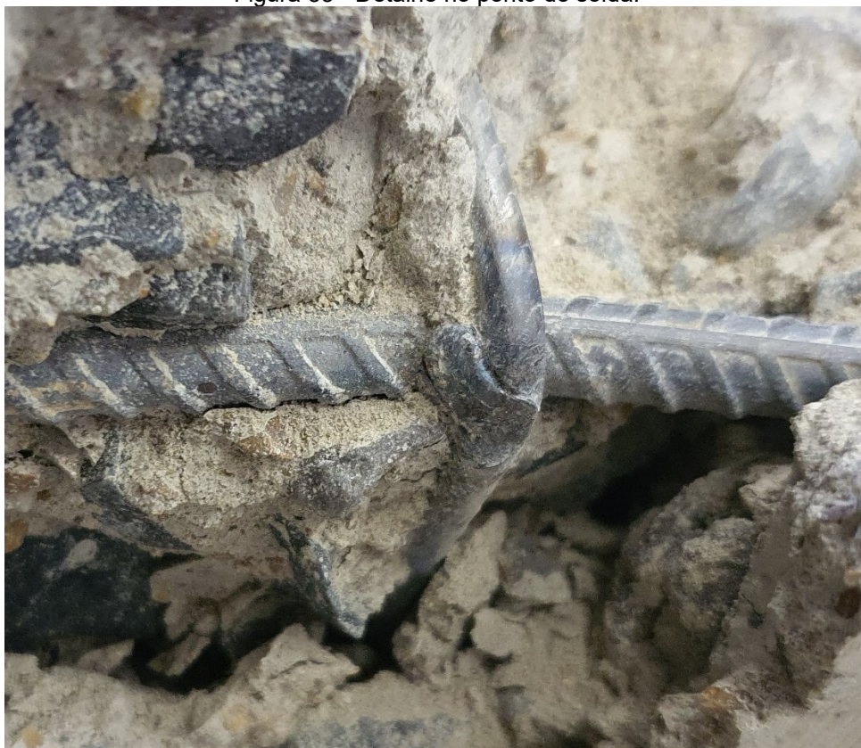
Figura 53 - Detalhe no ponto de solda.
