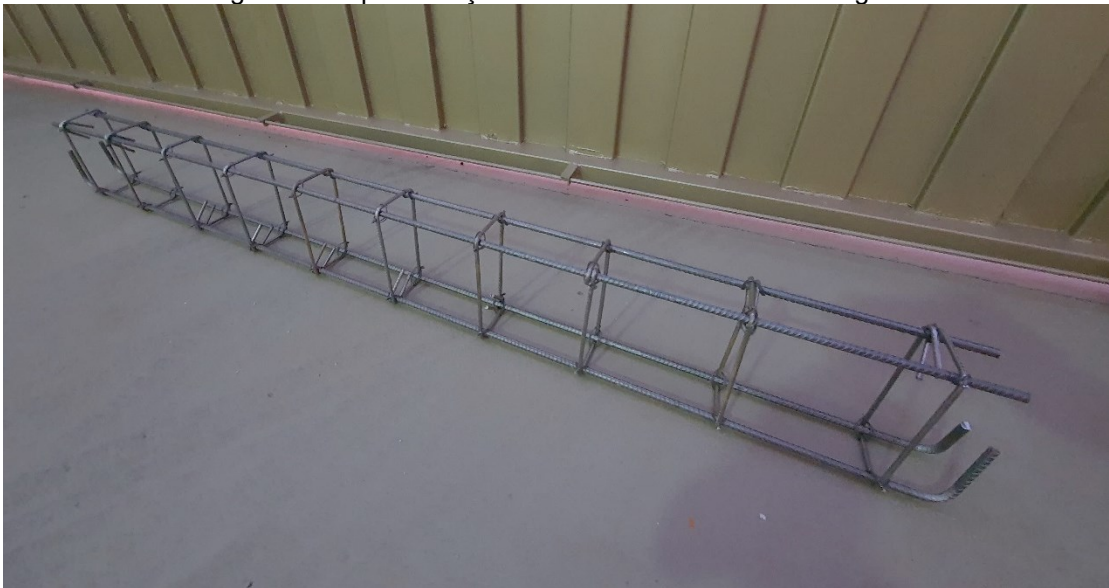
Figura 29– Apresentação da armadura montada das vigas.
