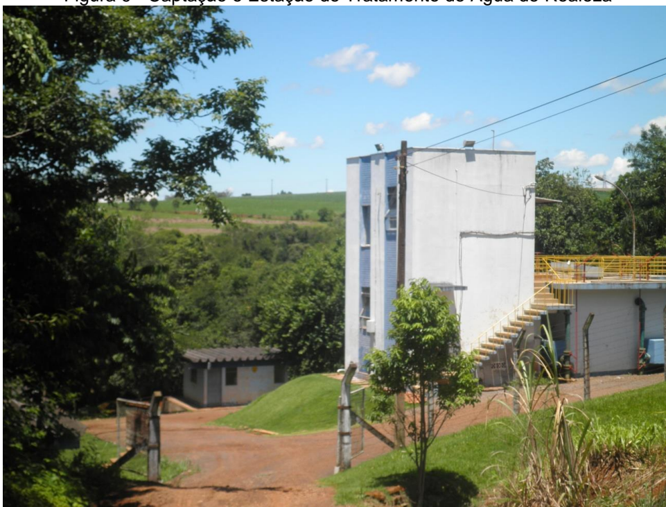
Figura 9 - Captação e Estação de Tratamento de Água de Realeza
