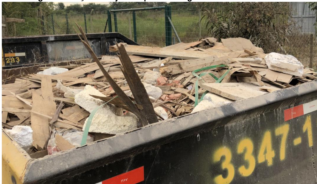
Figura 9 - Caçamba rejeitada pela heterogeneidade do material
