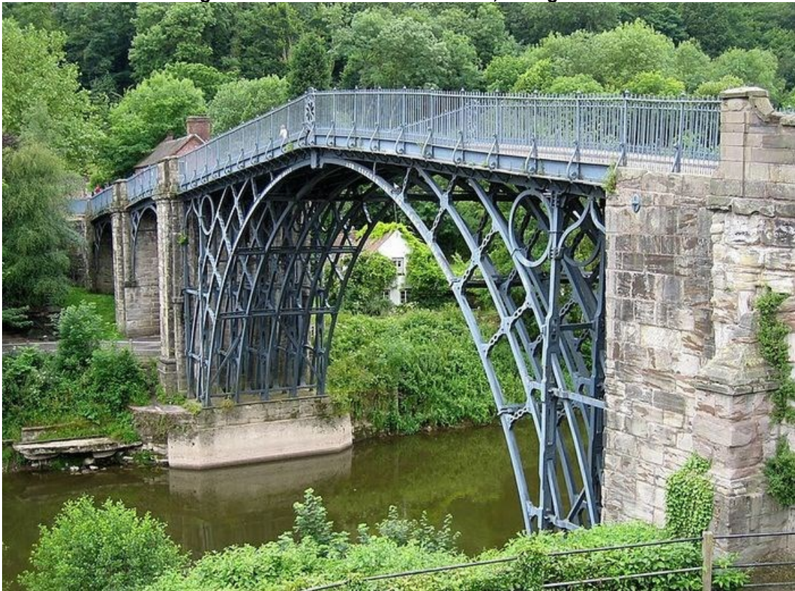
Figura 1 - Ponte sobre o rio Severn, na Inglaterra
