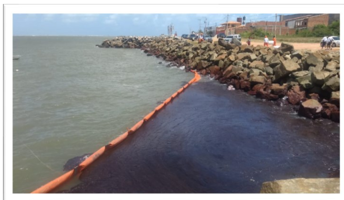
Figura 4: Barreiras de contenção
