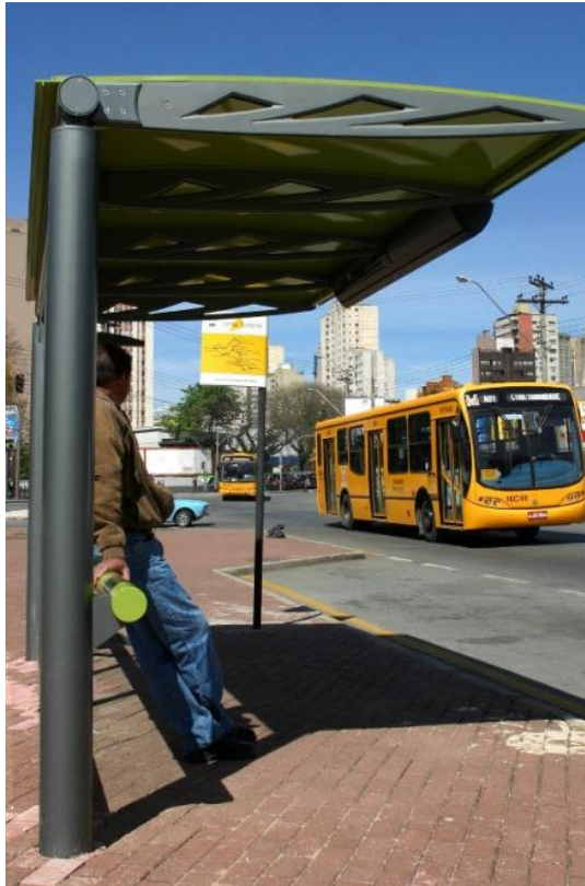
Figura 46: Ponto de ônibus da Clear Channel em Curitiba.
