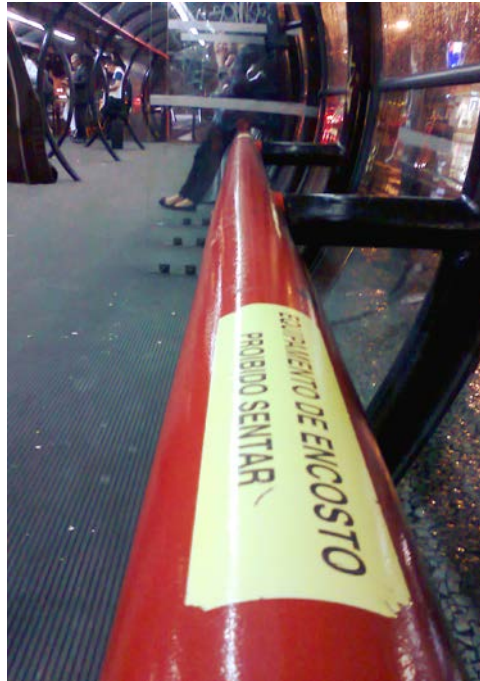
Figura 47: Imagem do interior de estação-tubo na Praça Rui Barbosa, Curitiba
