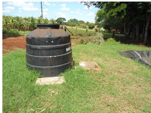
Figura 16 – Biodigestor vertical de fluxo ascendente. Modelo Biokohler®.
