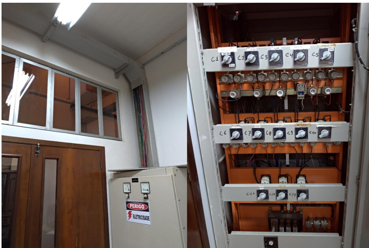
Figura 24: Visão externa e interna do QF-H002 Fonte: Autoria própria (2019)
