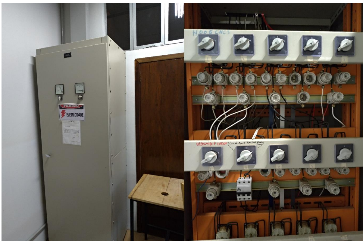
Figura 26: Visão externa e interna do QF-H004 Fonte: Autoria própria (2019)
