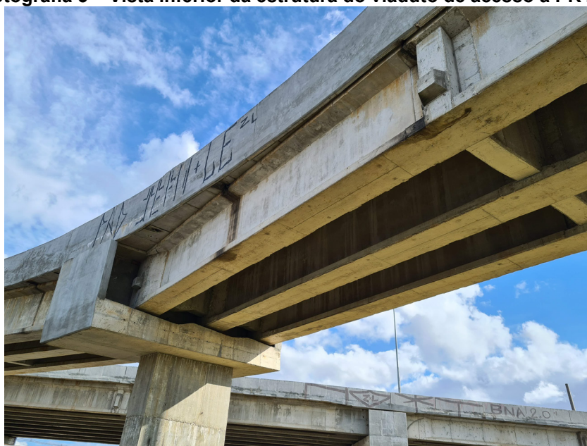
Fotografia 5 – Vista inferior da estrutura do viaduto de acesso a PR451.
