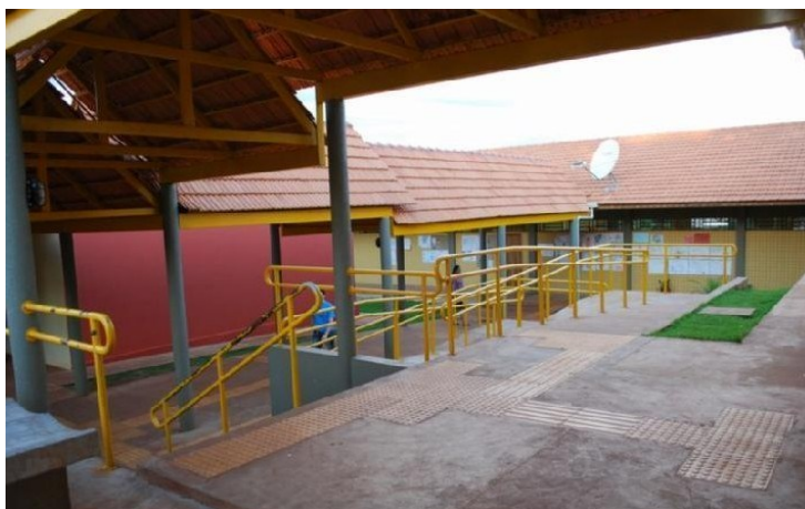
FIGURA 2 - Parte interna do Colégio
