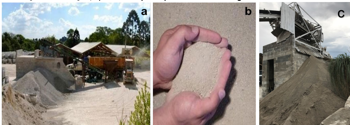
Figura 22 - a) Usina de reciclagem Soliforte Ltda.; b) areia proveniente de resíduo de construção e demolição; c) Última etapa do processo da reciclagem do RCD
