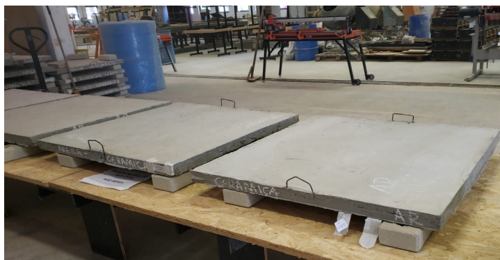
Figura 36– Contrapisos alinhados para aplicação de revestimento.
