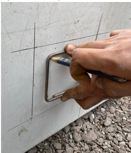
Figura 33 – Marcação do local do consolo
