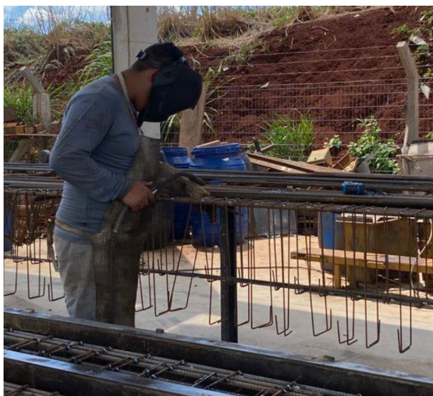
Figura 10 – Processo de armação
