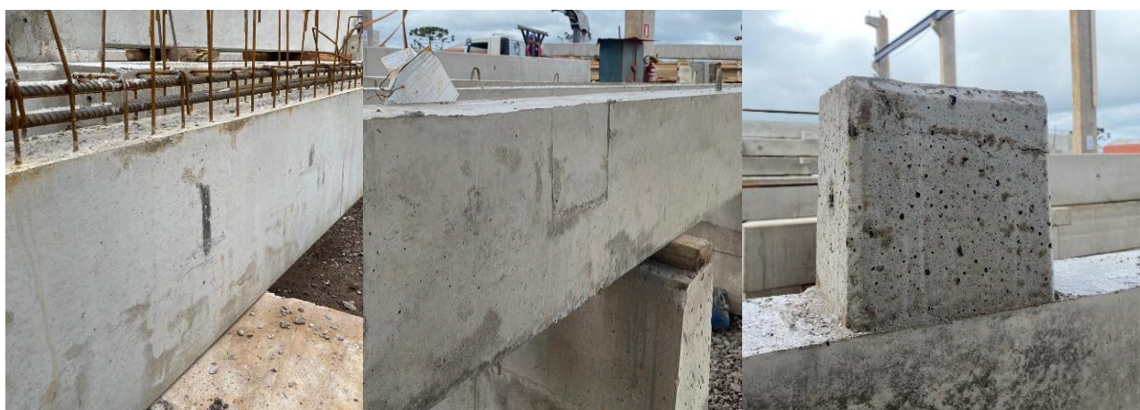
Figura 29 – Falhas na etapa de acabamento: (a) Peça suja; (b) Peça com marcas da fôrma; (c) Peça com bolha
