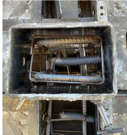
Figura G. 8 – Conduíte rígido e corrugado para substituição dos pinos
