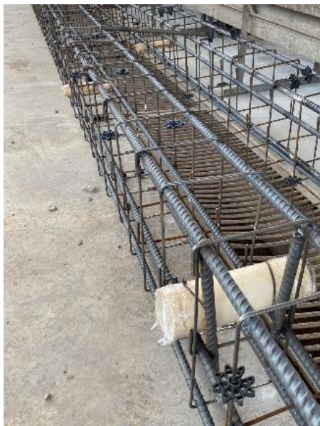
Figura G. 2 - Armaduras confeccionadas
