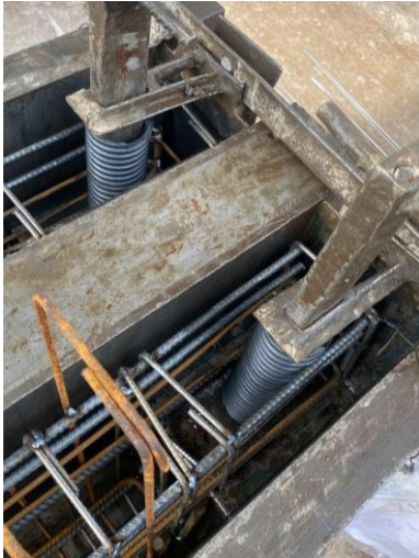
Figura G. 6 – Tubo corrugado para vigas
