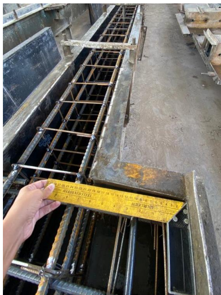
Figura 24 – Face inclinada do consolo
