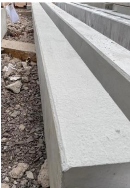
Figura 31 – Peça com chanfro de 45°
