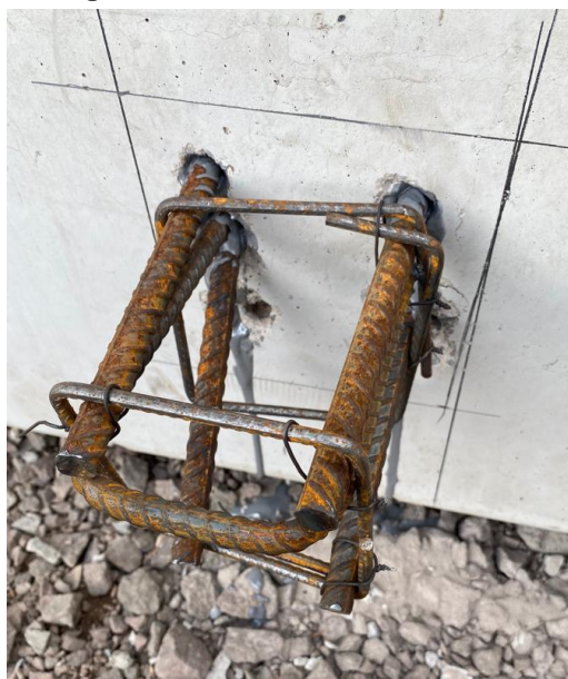
Figura 35 – Armadura de consolo
