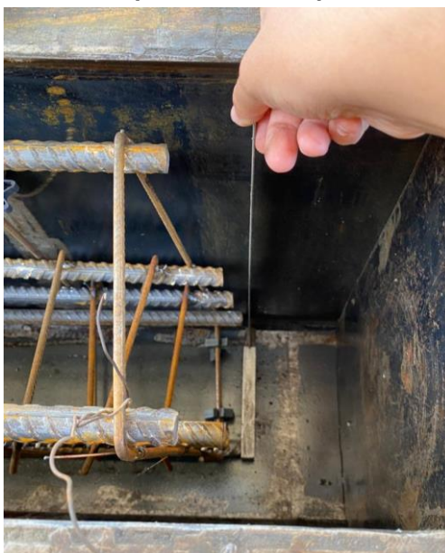
Figura 18 – Comprimento inadequado das barras
