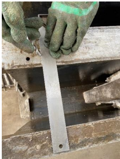
Figura G. 4 – Marcação com auxílio do esquadro
