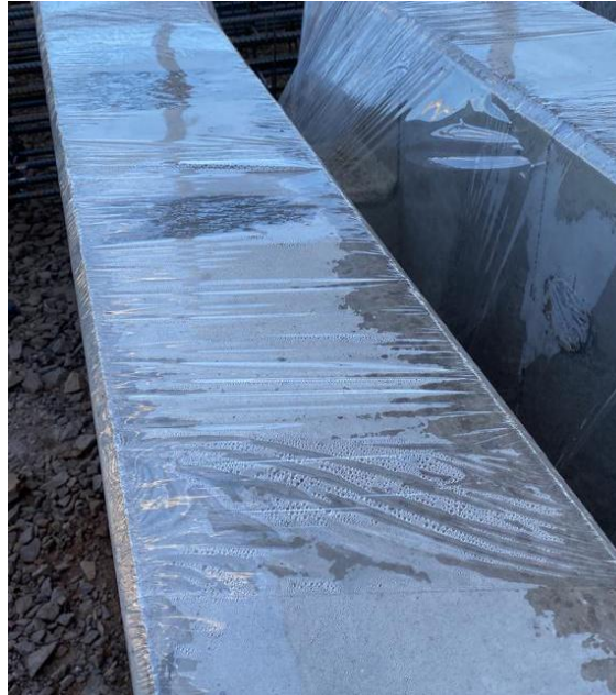
Figura G. 11 – Peça envelopada com stretch
