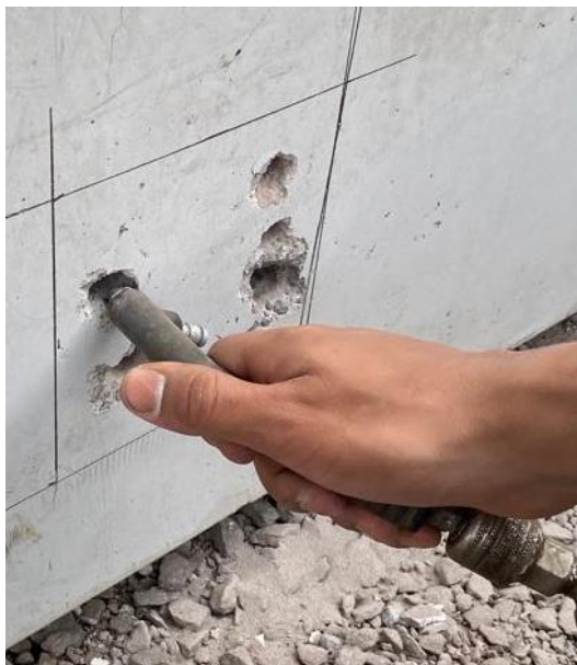
Figura 34 – Limpeza nas perfurações do concreto
