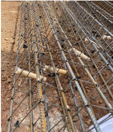
Figura G. 1 – Armaduras com espaçadores
