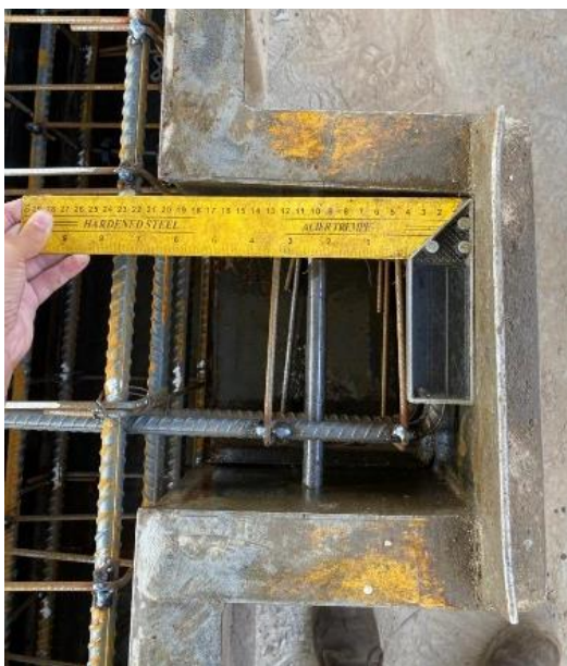
Figura 23 – Formato dos consolos nas fôrmas de pilares
