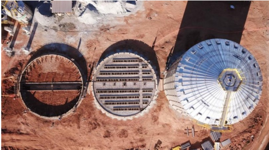
Figura 4 – Infraestrutura e Superestrutura – Silos
