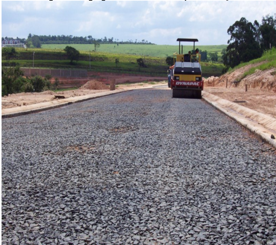
Figura 5 – Agregados reciclados em pavimentação
