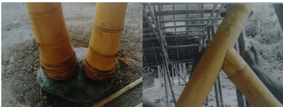
Figura 14 - Exemplo de ligações utilizando princípio do grupo 1
