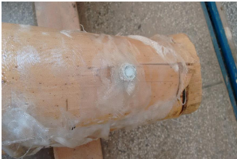
Figura 44 - Colapso iniciado nas proximidades da ligação
