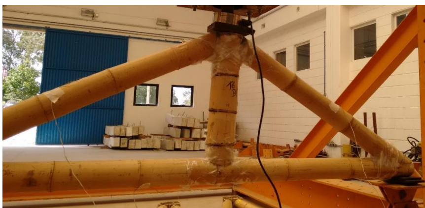
Figura 36 - Treliza com reforço de fibra de vidro na região da ligação
