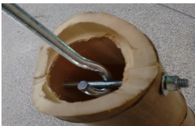
Figura 34 - Execução de ligação conhecida como “T” colombiano
