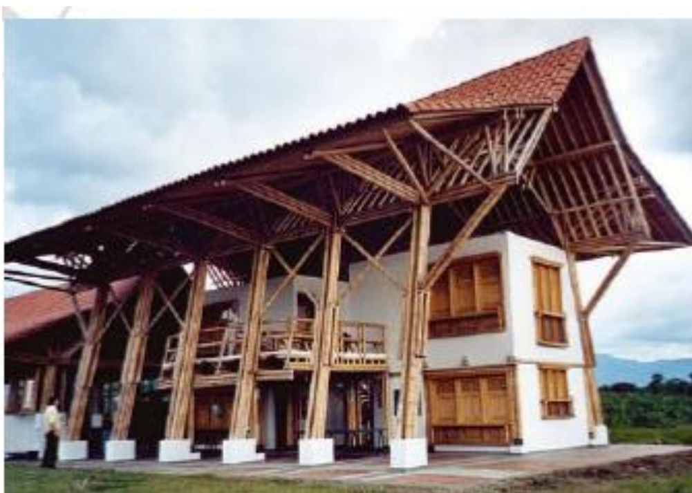
Figura 12 - Aplicação estrutural do bambu em edificação
