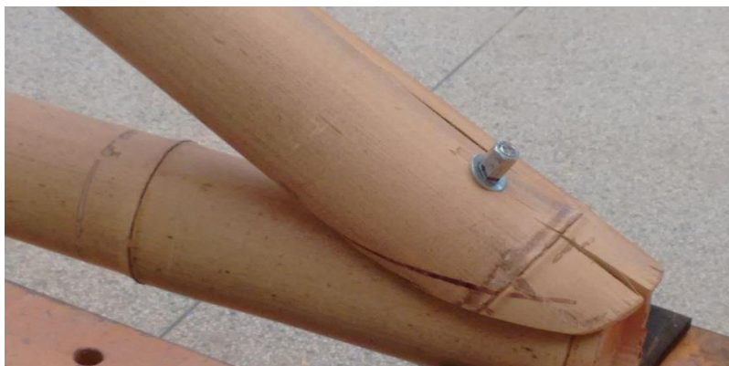
Figura 43 - Colapso iniciado por cisalhamento junto a ligação
