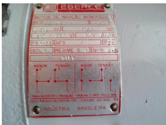
Placa de identificação do motor 3
