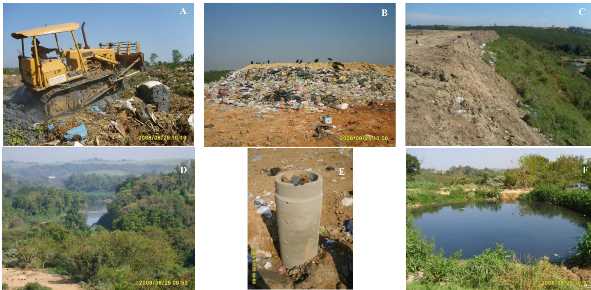
Figura 10 – Imagens do lixão de Porto Feliz, em 2008, ainda em fase de operação A – Compactação do material aterrado. B – Célula com cobertura de terra insuficiente. C – Célula encerrada. D –Rio Tietê visto do lixão. E – Dreno de gases. F – Lagoa de chorume.
