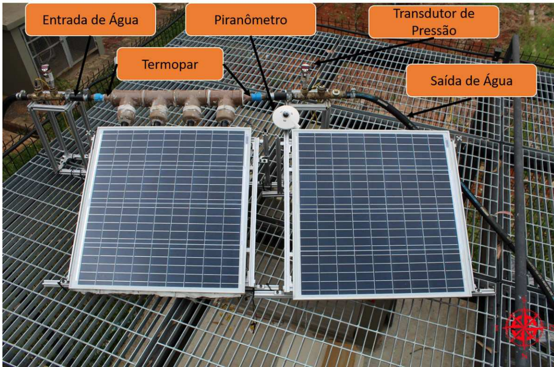
Fotografia 17 – Posicionamento dos painéis fotovoltaicos durante os testes
