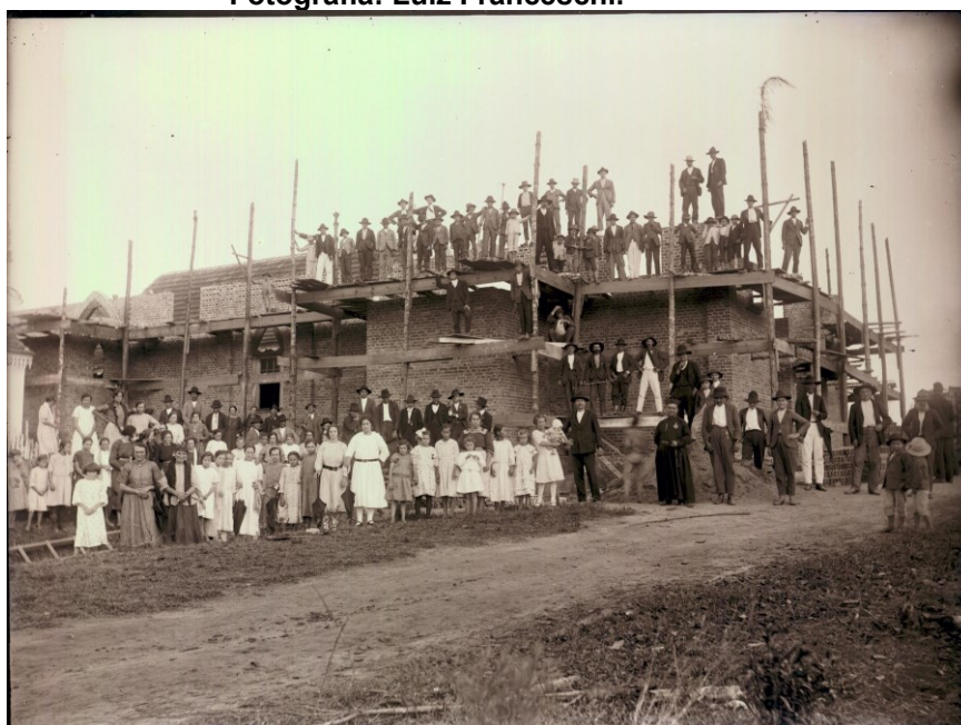
Imagem 21 - Construção da igreja da Colônia Faria, 1925. Fotografia: Luiz Franceschi.
