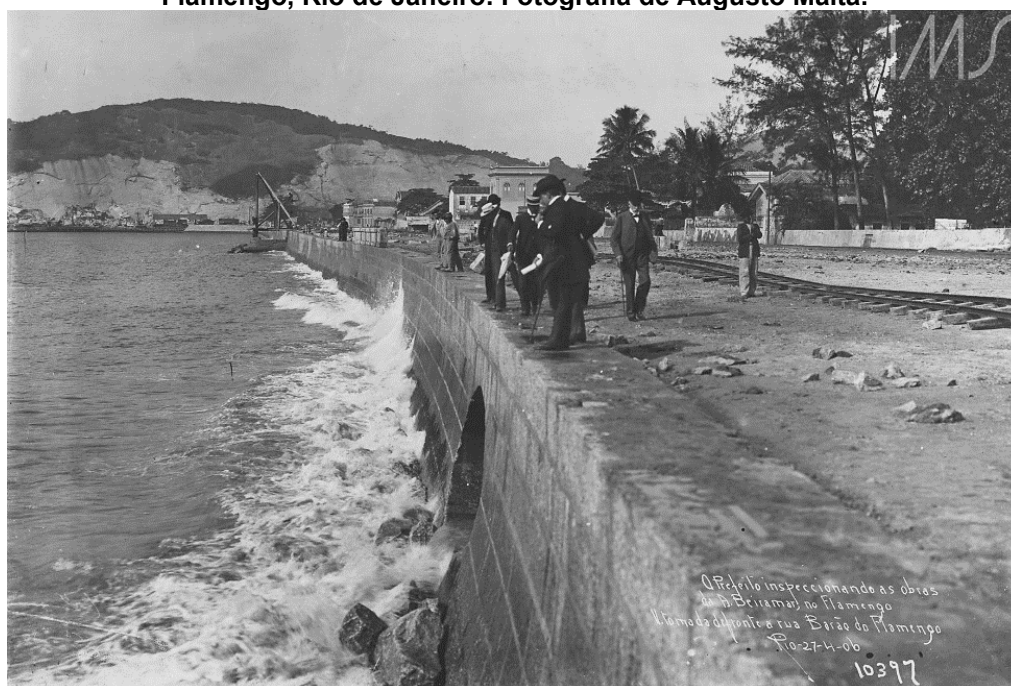
Imagem 12 - Prefeito Inspeccionando as Obras da Avenida Beira Mar, 27/4/1906. Flamengo, Rio de Janeiro. Fotografia de Augusto Malta.
