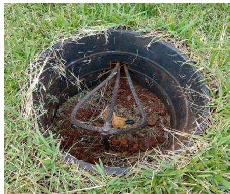
Figura 33: Caixa de inspeção 2 (Bloco P).
