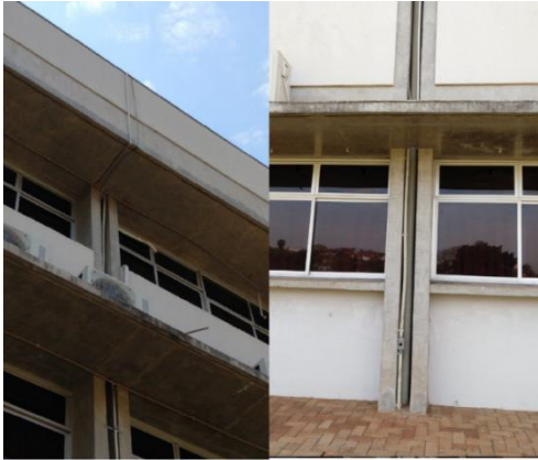
Figura 26: Descida 7 (Bloco P).
