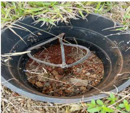
Figura 32: Caixa de inspeção 1 (Bloco P).
