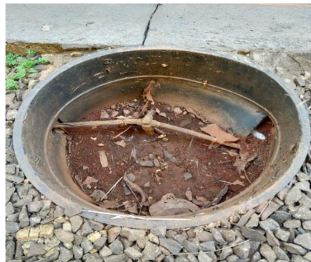
Figura 35: Caixa de inspeção 4 (Bloco P).
