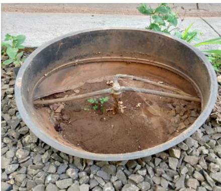
Figura 34: Caixa de inspeção 3 (Bloco P).
