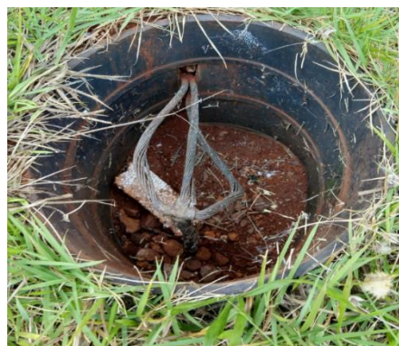
Figura 37: Descida 6 (Bloco P).
