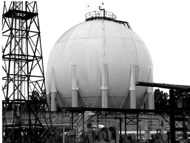
**Figura 1:** Vaso de alta pressão esférico.
