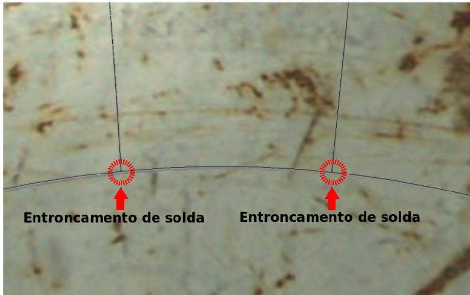
**Figura 22:** Exemplo de dois entroncamentos de solda vistos de dentro do vaso de pressão esférico.
