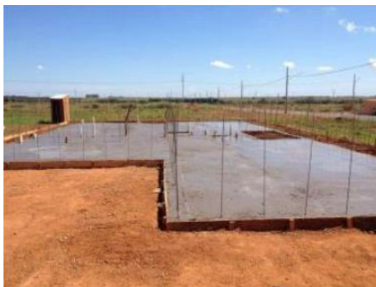
Figura 11: Arranque de fôrmas ICF Fonte: ICF Construtora inteligente, 2021.
