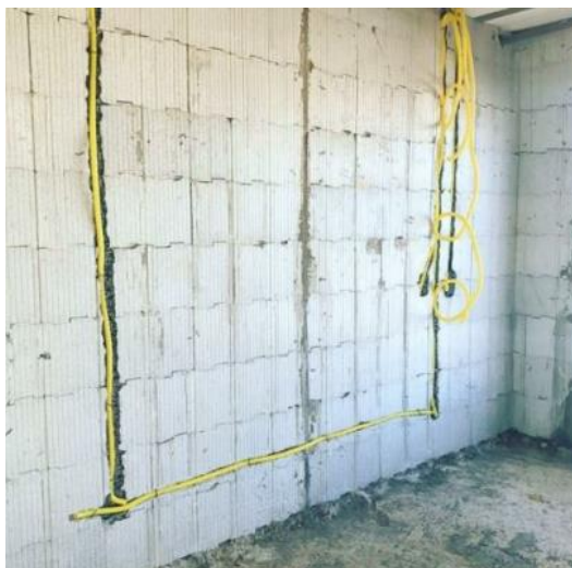
Figura 33: Instalação Elétrica embutida na fôrma Fonte: Autoria própria
