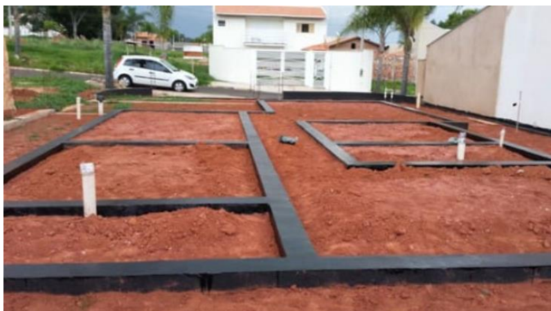
Figura 25: Vigas Baldrame Fonte: Viva Decora, 2020
