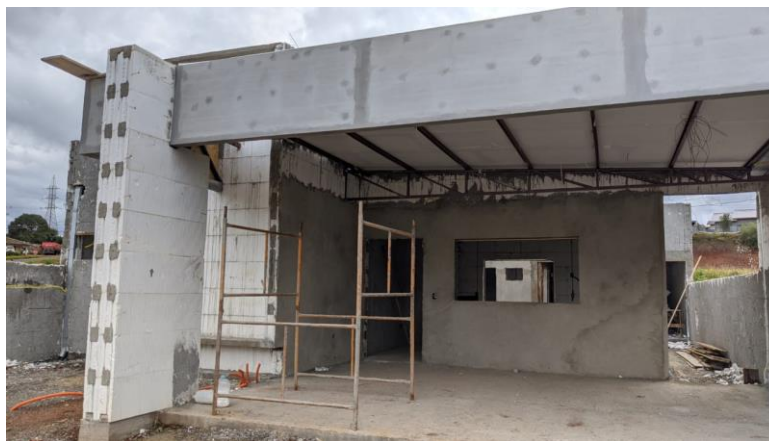
Figura 34: Reboco executado em ICF Fonte: Autoria própria
