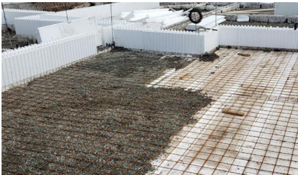
Figura 28: Primeiras fiadas de blocos ICF com radier Fonte: Fase ICF, 2021
