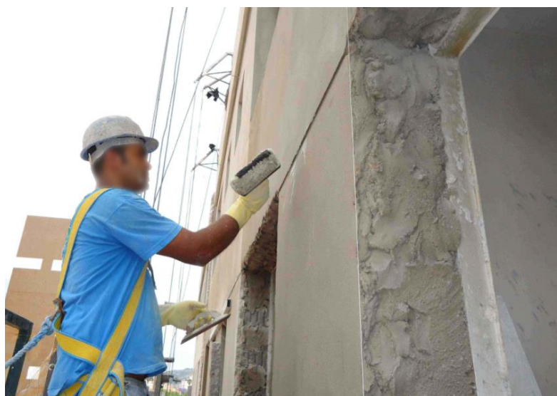
Figura 35: Reboco executado em alvenaria Fonte: UFRGS, 2013.
