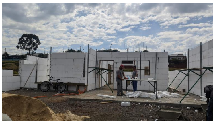
Figura 7: Canteiro de obra com sistema construtivo ICF Fonte: Autoria Própria
