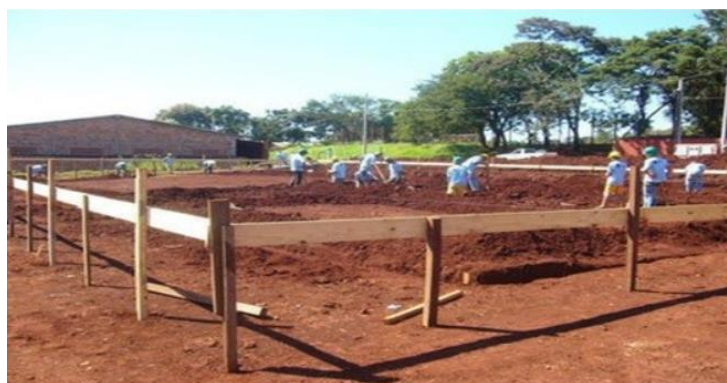
Figura 24: Locação de obra Fonte: Neoipsum, 2021.
