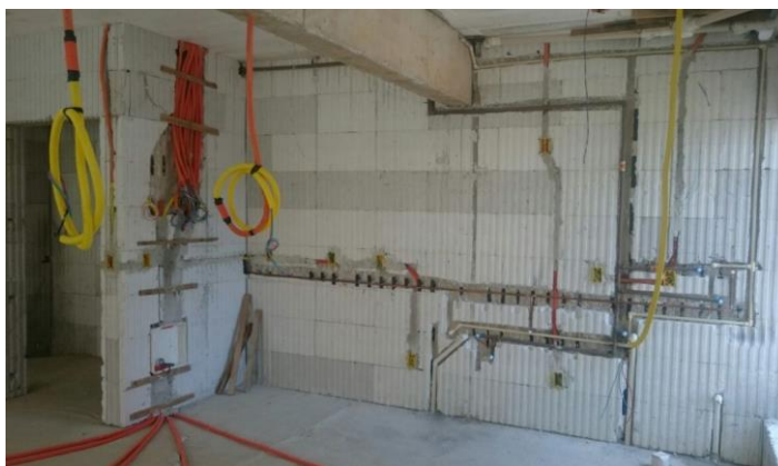
Figura 14: Embutimento de instalações nas paredes ICF Fonte: Inconcreto (2021)
