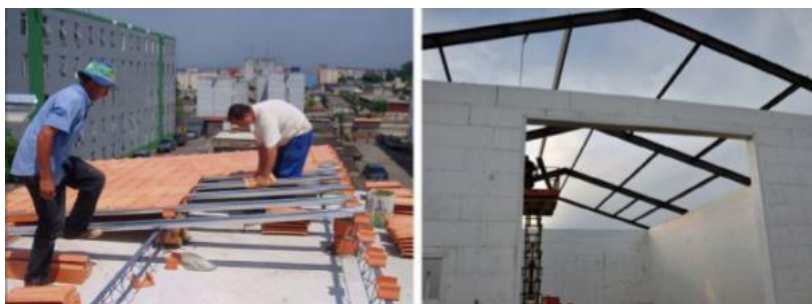
Figura 17: Cobertura sistema tradicional Fonte: Canteiro de obra ICF
