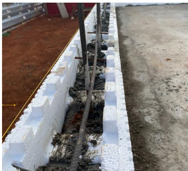
Figura 3: Parede de ICF Fonte: ICF Construtora inteligente, 2021, p. 19
