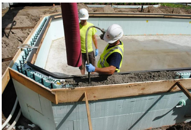
Figura 31: Concretagem de fôrmas ICF Fonte: Estudio BIM (2020)
