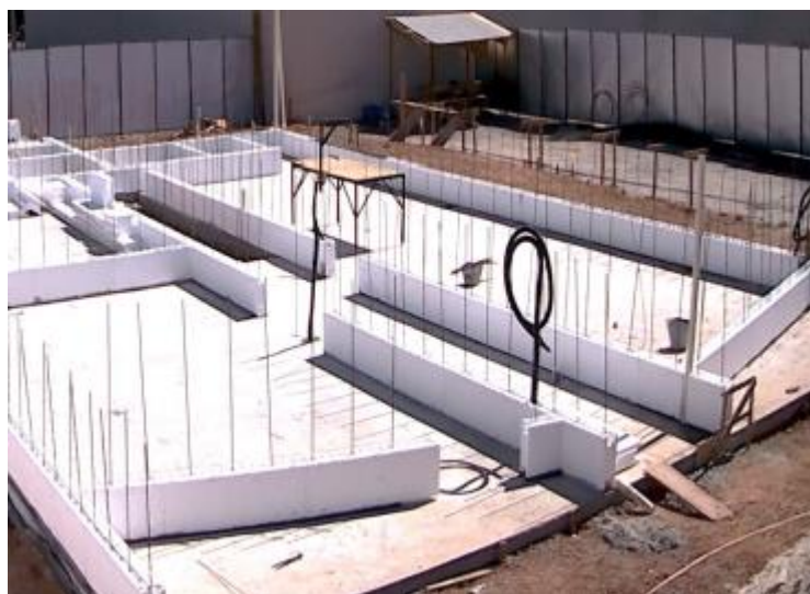
Figura 29: Primeira fiada de blocos ICF com arranques Fonte: ICF Construtora, 2021.
