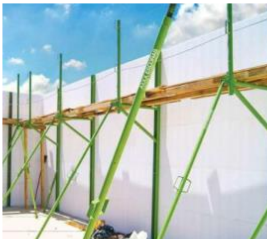
Figura 30: Parede escorada e prumada Fonte: ARXX, 2021.
