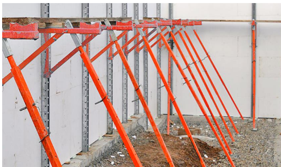
Figura 13: Escoramento das fôrmas ICF Fonte: ARXX INC, 2021
