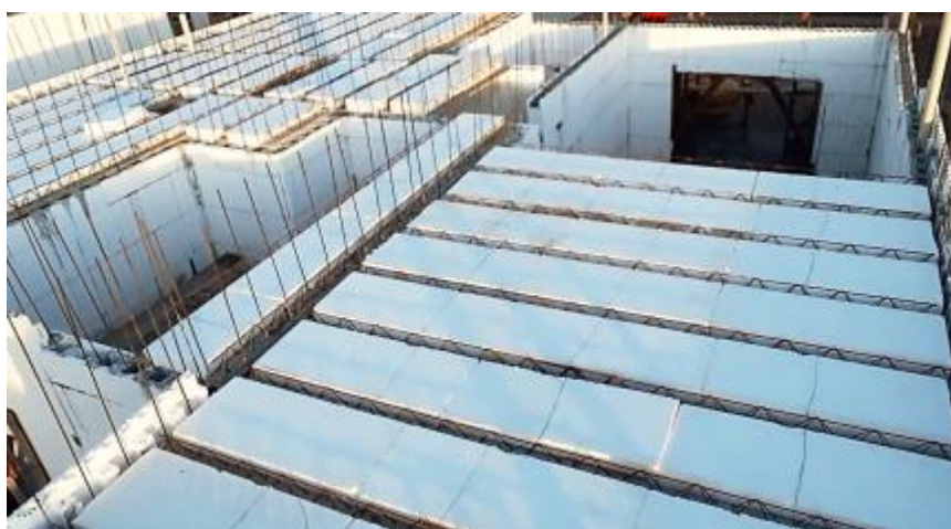
Figura 16: Laje treliçada com preenchimento em EPS – Sistema Construtivo ICF Fonte: ICF Construtora Inteligente, 2021
