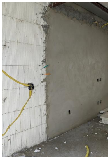
Figura 15: Revestimento em fôrmas de ICF Fonte: autoria própria
