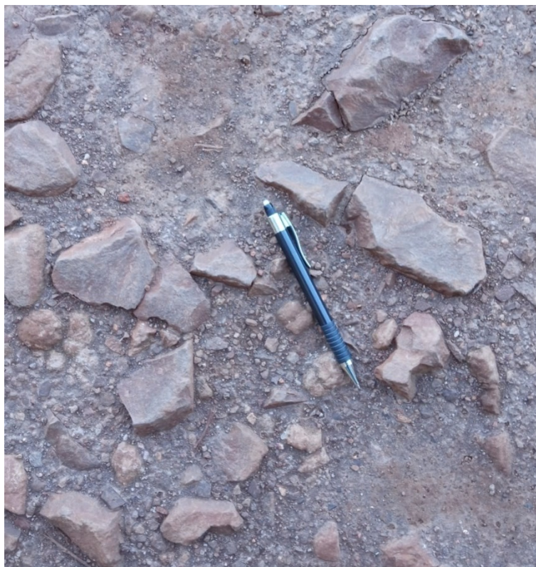
Figura 76: agregados graúdos aparentes na camada de revestimento Fonte: autoria própria (2021).
