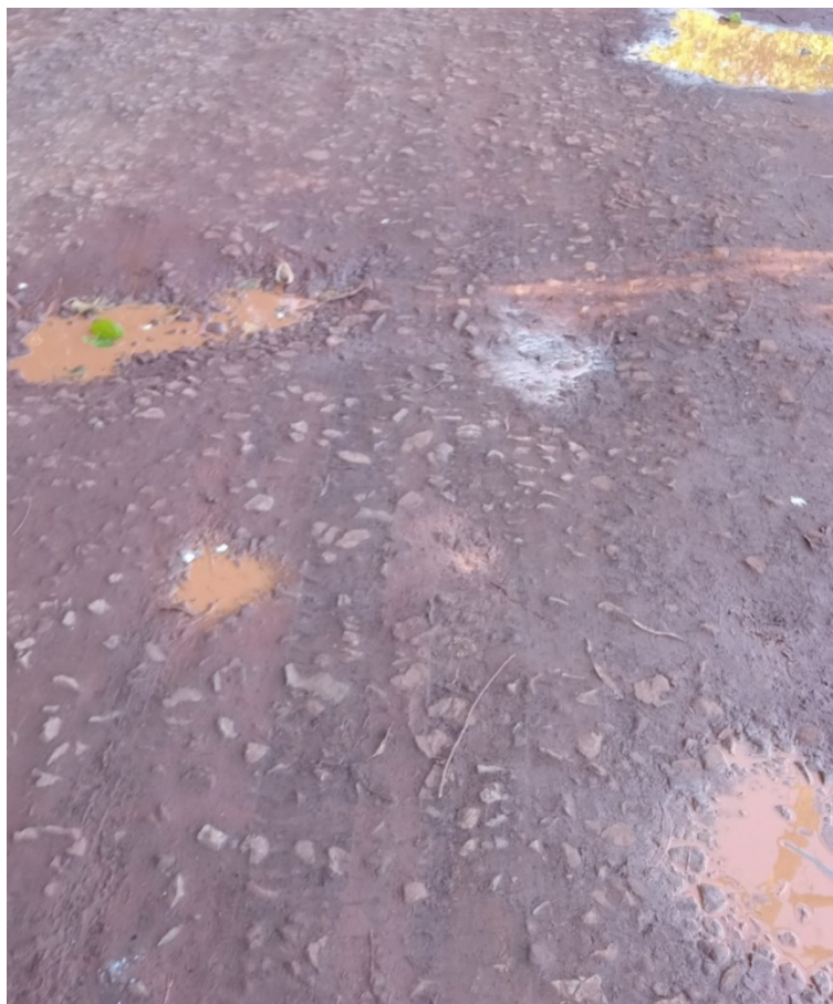
Figura 75: buracos formados na seção transversal Fonte: autoria própria (2021).
