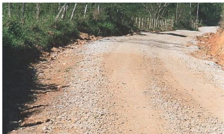
Figura 27: segregação de agregados Fonte: Baesso e Gonçalves (2003).
