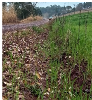
Figura 83: a) não há indicação de sarjeta de drenagem e b) sarjeta muito abaixo do leito da pista e com muita vegetação Fonte: autoria própria (2021).
