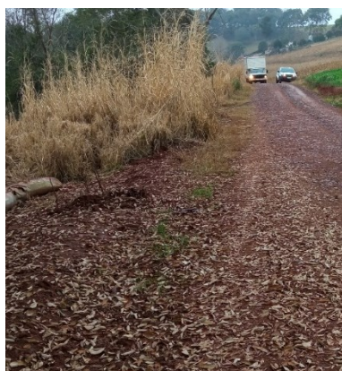
Figura 83: a) não há indicação de sarjeta de drenagem e b) sarjeta muito abaixo do leito da pista e com muita vegetação Fonte: autoria própria (2021).
