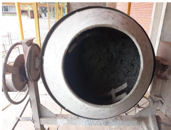
Figura 33 - Imprimação da betoneira - Autoria Própria 2021
