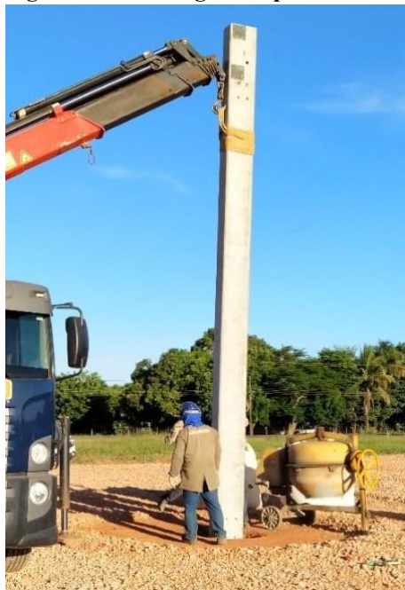
Figura 21 – Montagem do pilar em obra
