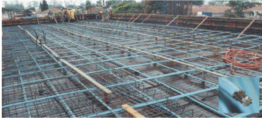
Figura 3 – Laje Protendida. Fonte: NTCBrasil – Materiais para Construção.
