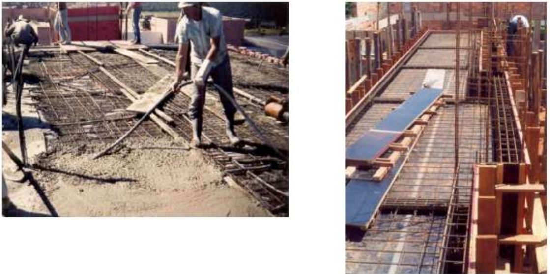
Figura 02– Laje Maciça Fonte: Fundamentos do Concreto Armado, 2006.
