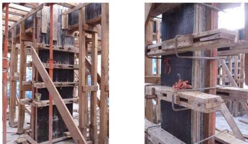
Figura 5 – Pilar de concreto armado Fonte: Fundamentos do Concreto Armado, 2006.
