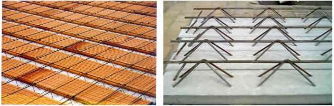
Figura 01 – Laje Trelaçada Fonte: Fundamentos do Concreto Armado, 2006.
