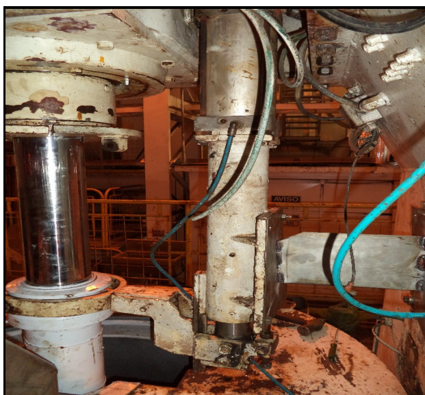
Figura 41 - Acionamento de Abertura e Fechamento de Fundo antigo
