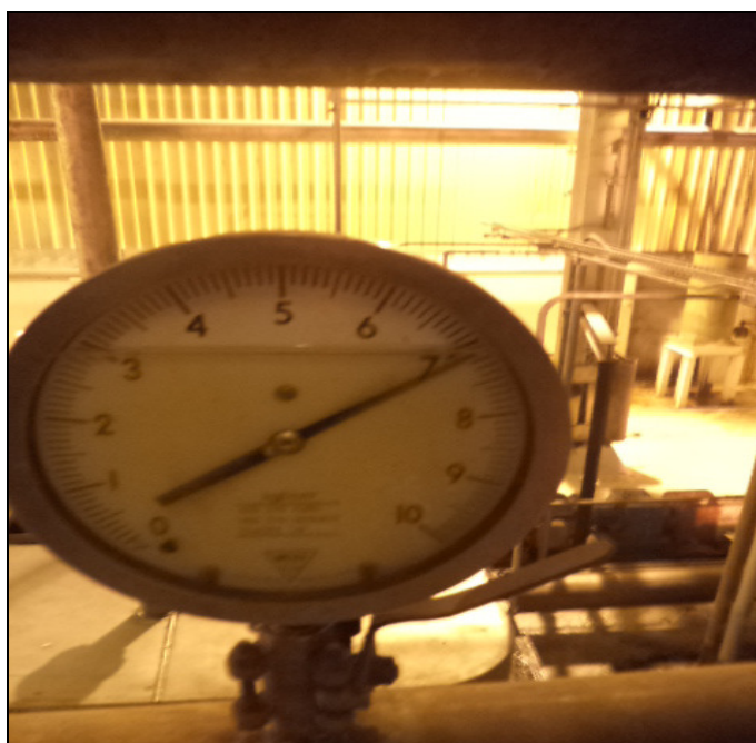
Figura 45 - Manômetro na linha que fornece ar para as centrífugas Fonte: Raízen (2015)
