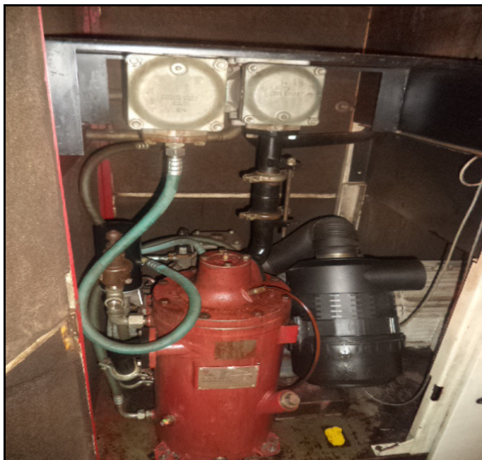
Figura 11 - Reservatório de ar comprimido
