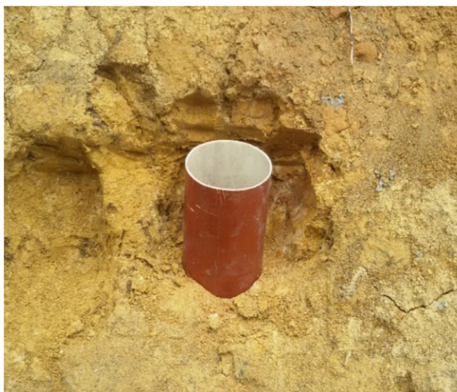
Figura 13 - Posicionamento do tubo de PVC para retirada de amostra indeformada Fonte: Matsubara (2015)
