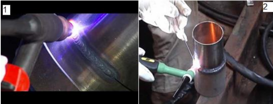
Figura 2 - 1) Soldagem TIG autógena; 2) Soldagem TIG com metal de adição. Fonte: MARQUEZ (2004).
