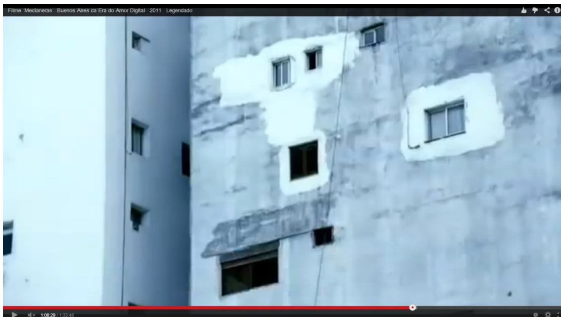
Figura 14 - Buenos Aires, vista de aberturas irregulares sobreparedes de divisa. Fonte: MEDIANERAS, 2011.
