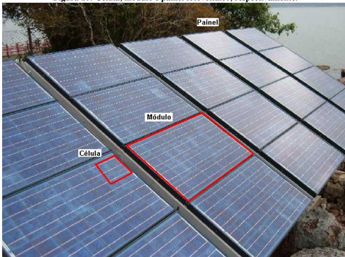
Figura 10: Célula, módulo e painel fotovoltaico, respectivamente.
