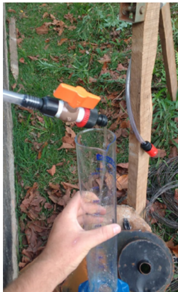
Figura 22 – Determinação da vazão na saída da bomba
