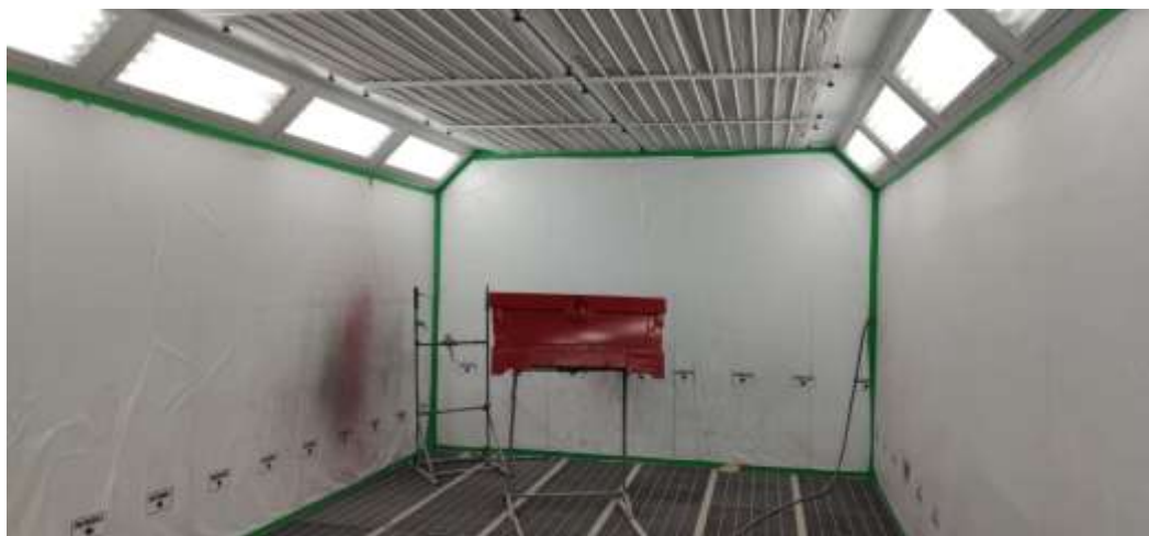
Figura 32 - Pintura Realizada na Cabine de Pintura
