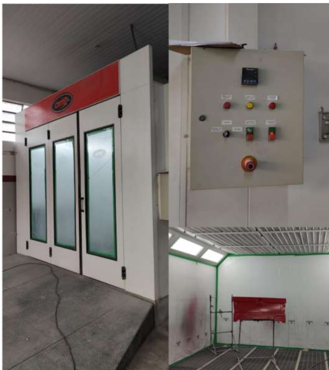
Figura 30 - Imagens Visita Técnica
