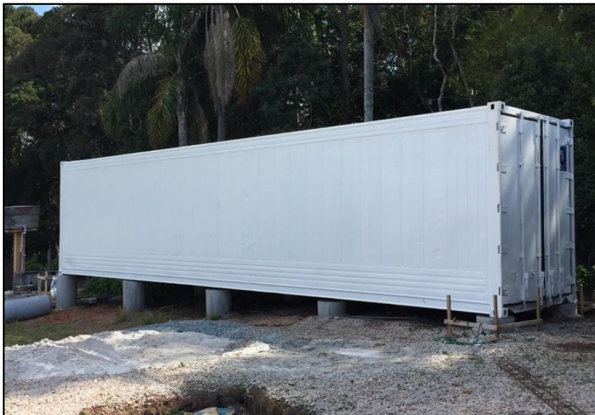
Figura 15 – Container que funcionará como câmara fria.
