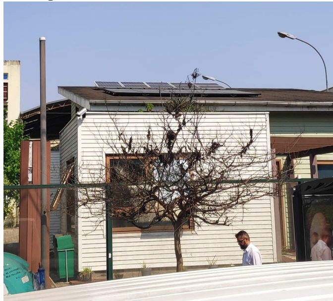
Figura 21: Vista lateral do Escritório Verde.
