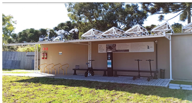
Fotografia 1 – Estação de carregamento na sede do Lactec.
