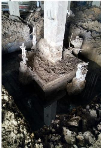
Figura 22 - Reforço dos blocos de coroamento e estacas
