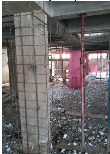
Figura 23 - Reforço dos pilares e vigas
