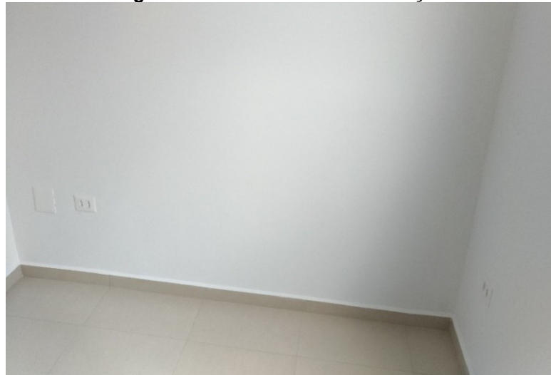
Figura 31 - Parede de uma habitação
