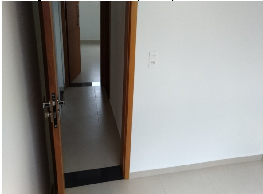
Figura 37 - Acabamento do piso do quarto e corredor
