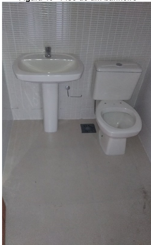
Figura 40 - Piso de um banheiro
