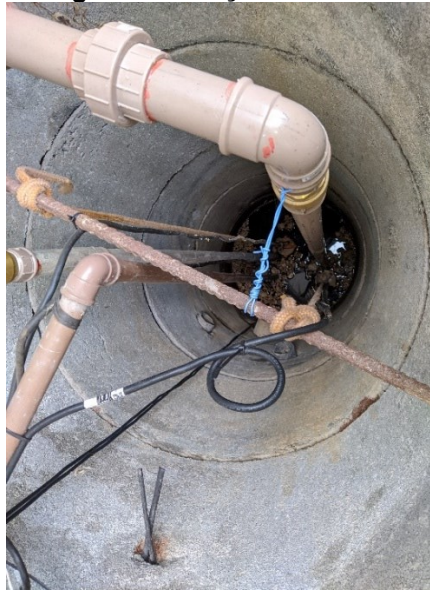
Figura 49 - Poço do edifício
