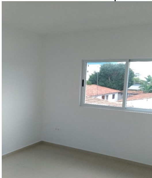
Figura 34 - Acabamento do teto e da parede no quarto
