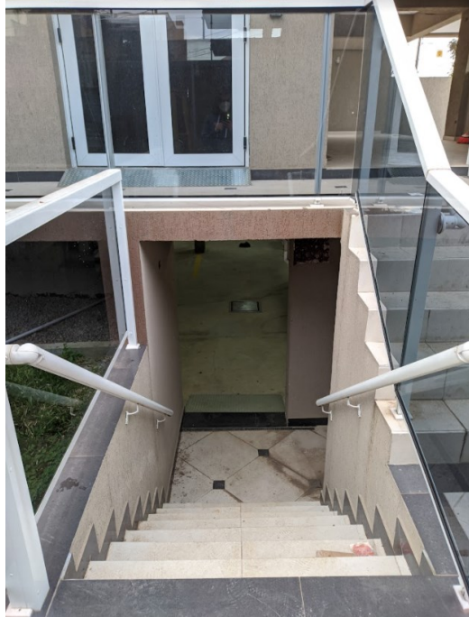
Figura 43 - Escada de acesso ao estacionamento
