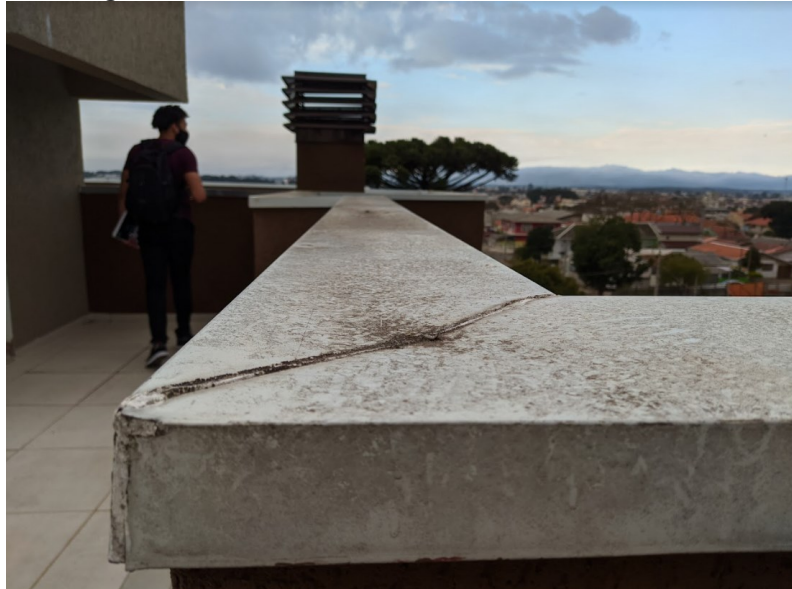
Figura 58 - Condição de um dos rufos da cobertura
