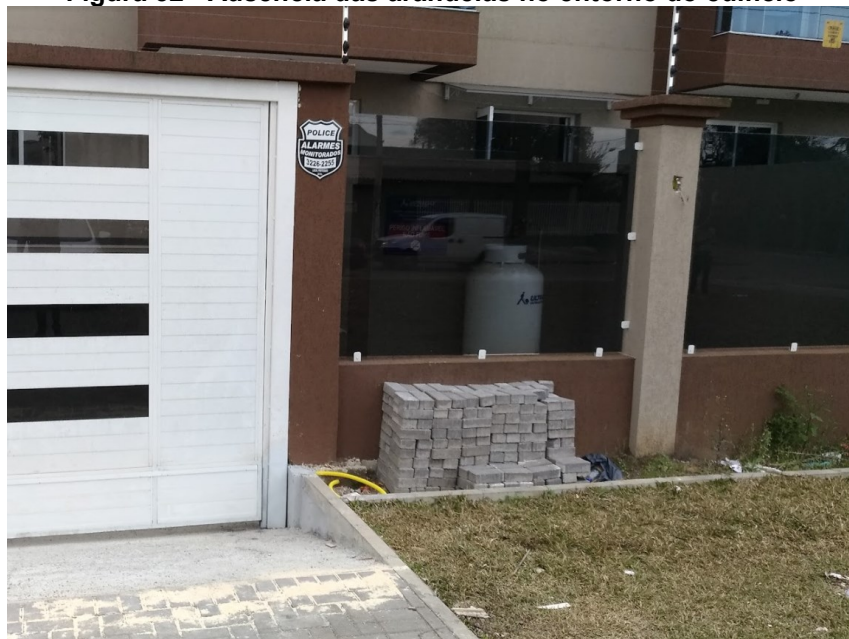
Figura 52 - Ausência das arandalas no entorno do edifício
