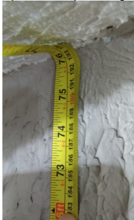
Figura 26 - Medição da altura do piso até a viga de sustentação
