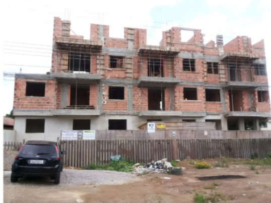
Figura 21 - Estrutura em construção
