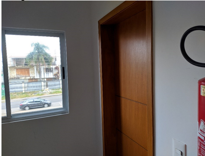
Figura 46 - Porta de entrada de uma unidade habitacional
