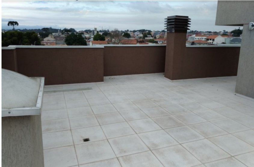
Figura 56 - Cobertura do edifício
