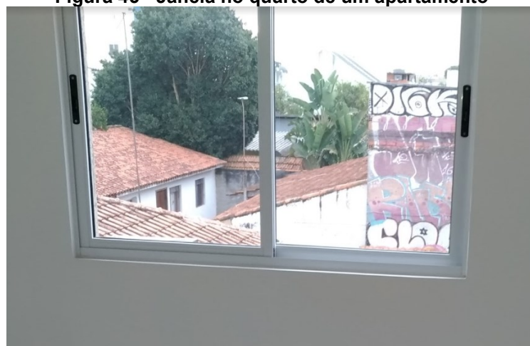
Figura 45 - Janela no quarto de um apartamento
