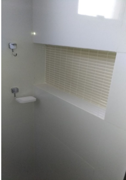
Figura 39 - Nicho da parede de um banheiro
