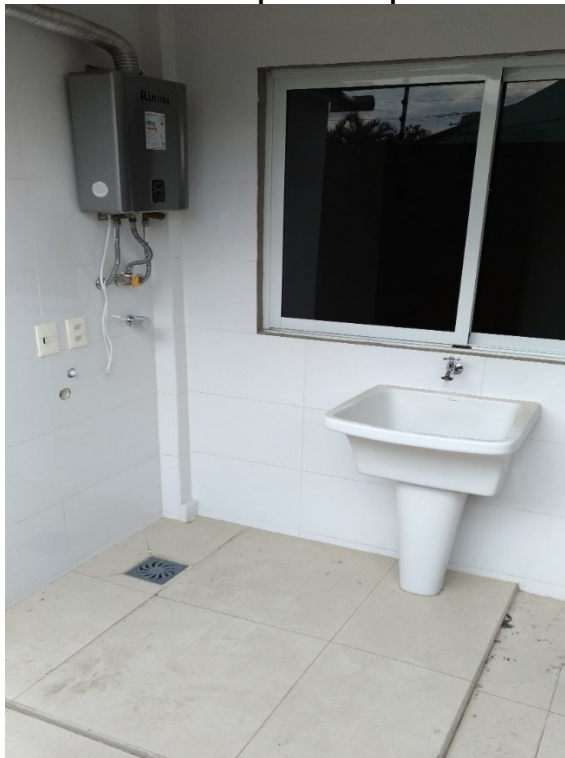
Figura 36 - Acabamento das paredes e piso da área de serviço
