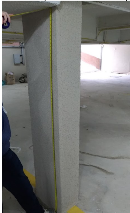
Figura 25 - Determinação da altura entre o piso e a viga
