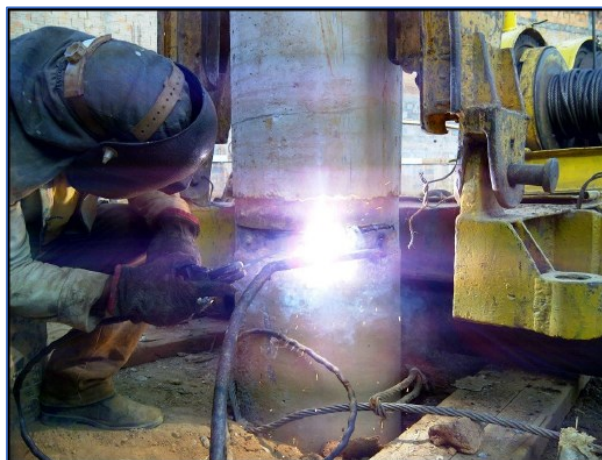
Figura 6 - Emenda de estaca com solda de anéis
