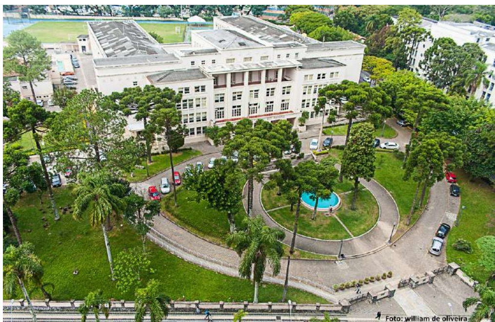
Fotografia 20 - Imagem aérea registrada por drone
