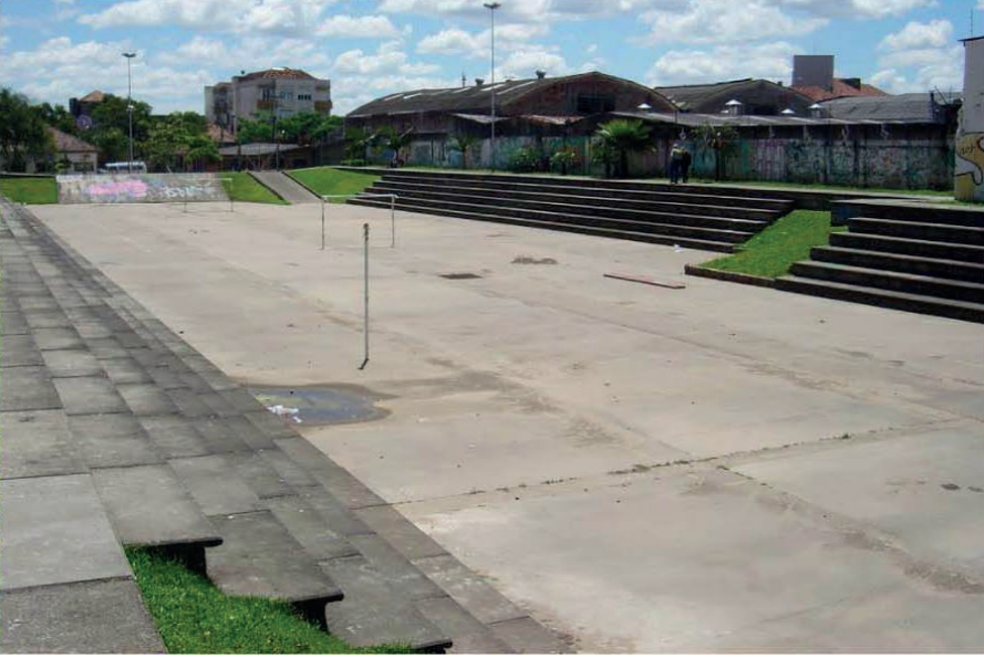
[F3] Biovaleta; canteiros de chuva como canteiros de via pública; piso permeável e bacia de retenção com uso alternativo de quadra esportiva. Fonte: UNEP-DHI Partnership et al. (2014); Dunnet e Clayden (2007); CLIMATEAPP (2016) .
