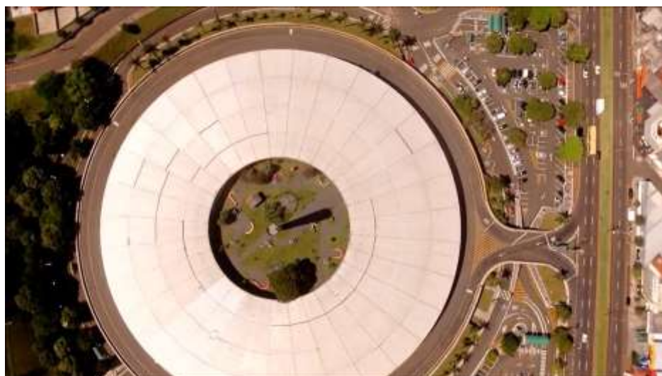
Figura 10: Imagem realizada com drone
