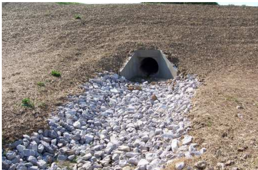
Emissário com plataforma com enrocamento
