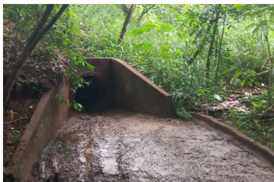
Emissário com plataforma
