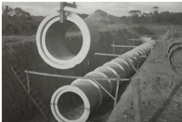
Manilhas de concreto galeria de águas pluviais
