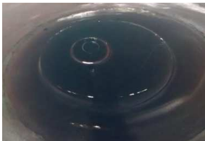
Vista interna de tubulação de drenagem de águas pluviais
