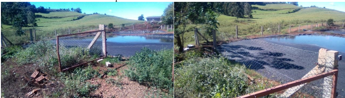
Foto 02 - Resíduos de suínos esterqueira
